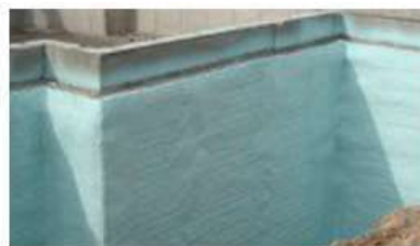
Рис.3. Гідроізоляція фундаменту полімерна мембрана
