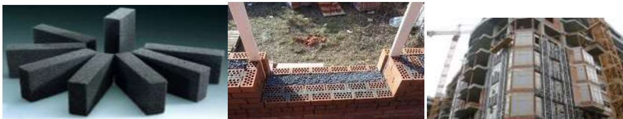
Рисунок 1. Варіанти утеплення піносклом
