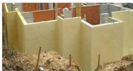
Рис.2. Гідроізоляція фундаменту – рідка гума
