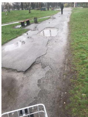
Рис. Б.1. Незадовільний стан елементів благоустрою (фото автора): а – майже зруйноване дорожнє асфальтове покриття; б – бювет; в - існуючий стан дитячих майданчиків
