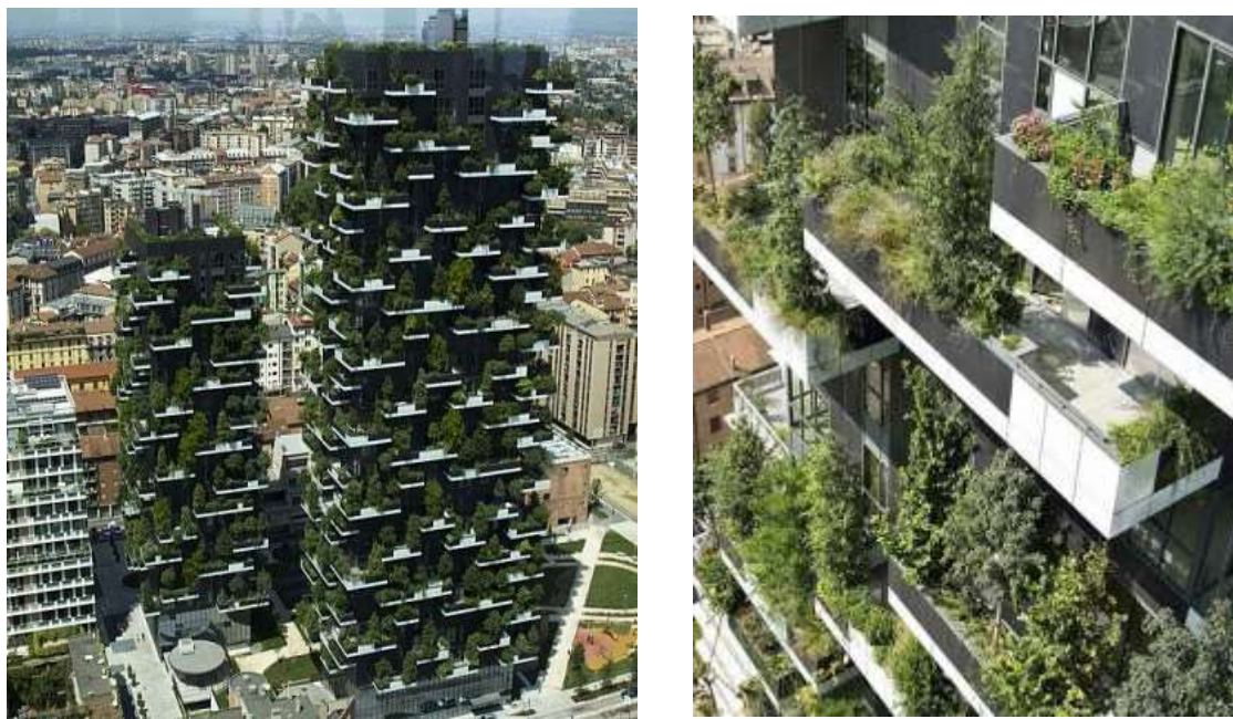
Рис. Г.1. Загальний вигляд «Вертикального лісу» в Мілані [27], [31].
