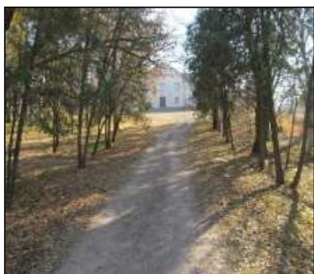
Рисунок 2.4 – Існуючий стан дорожнього покриття
