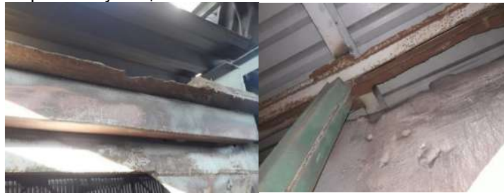
Рисунок.1 Ураження верхніх поясів ферм пластовою корозією із значним зменшенням перерізу.
